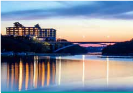
C-3 賢島大橋
