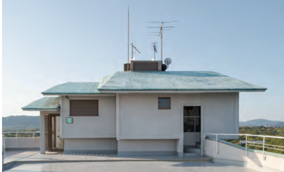
「ザ クラシック」の屋上にある塔屋
