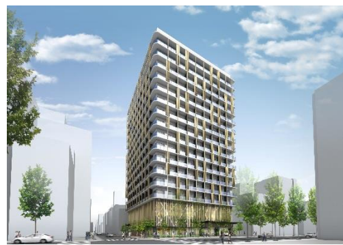
(仮称)堺筋本町ホテル外観イメージ
